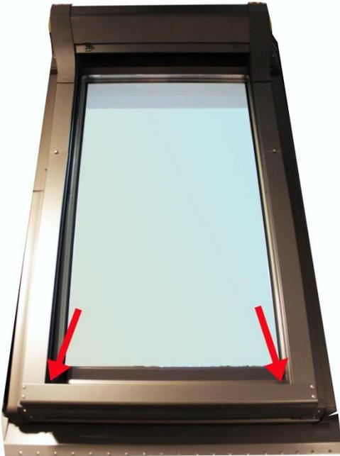
In den Ecken der Führungsschienen befinden sich Umlenkrollen. Sie sollen 1-2-mal jährlich mit harz- und fettfreiem Wartungsölspray gewartet werden.
